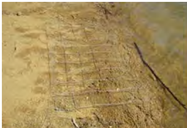
Figura 05: Colocação dos pinos de controle de gradeamento na margem do reservatório, foto retirada no sentido sul. Fonte: SOARES, 2015.
