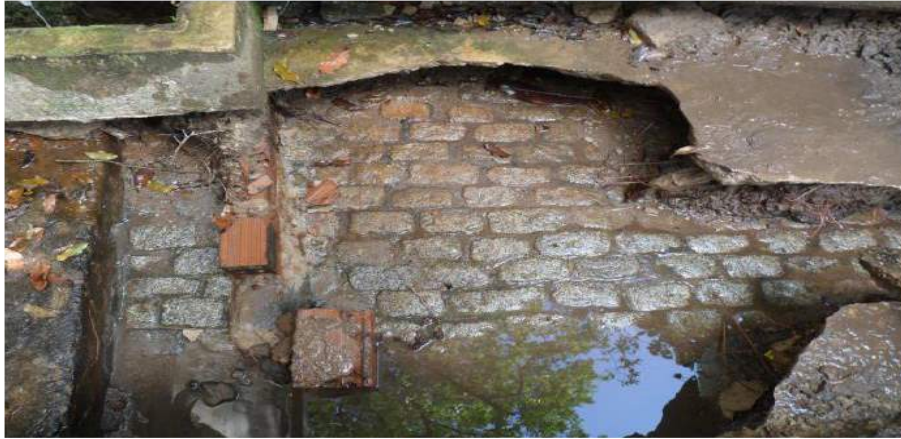
Figura 6: 1º piso: vigas e cimento; 2º piso: blocos (tijoleira). Fonte: dados da pesquisa
