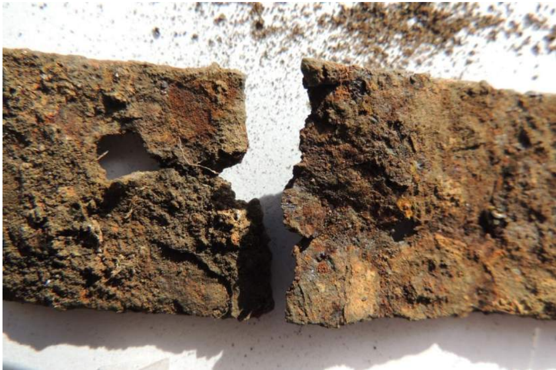
Figura 14: Deformidades e torções no suporte metálico. Fonte: Isabel Halfen Torino
