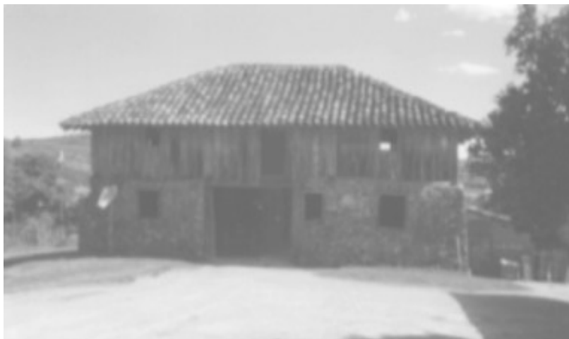
Foto 08: Casa de pedra localizada na Vila Maciel, distrito do Rincão da Cruz, construída por imigrantes italianos em 1888.
