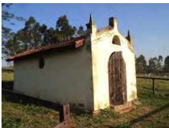
Figura 28: Vista lateral da pequena capela. Foto extraída do Relatório de Prospecção Trecho 2 (Fonte: ECOSSIS, 2015, p. 103).
