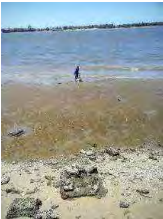
Figura 05: Estrutura 2 – fundação da ponte de embarque do hotel Brasil. Foto do autor, 2016.
