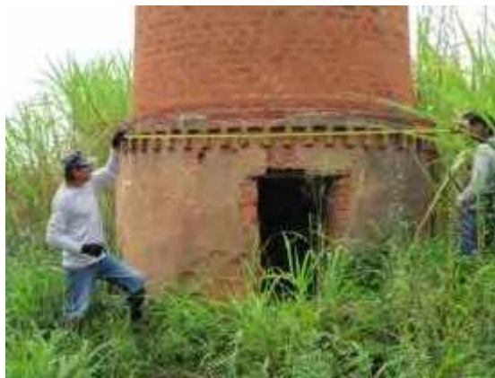
Figura 06: Medição da base da chaminé. UTM (SAD 69) 23K 0258.367E / 7.7512.543N. Foto extraída do Relatório de Prospecção Trecho 2 (Fonte: ECOSSIS, 2015, p. 121).
