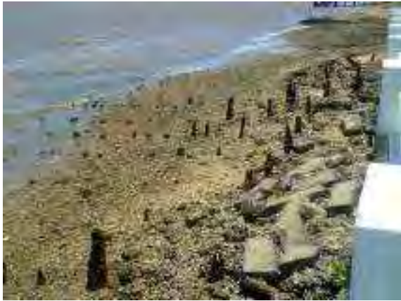
Figura 03: Estrutura 1 - vestígios dos pilotis da ponte do trapiche Lima, a partir do norte. Foto do autor, 2014.
