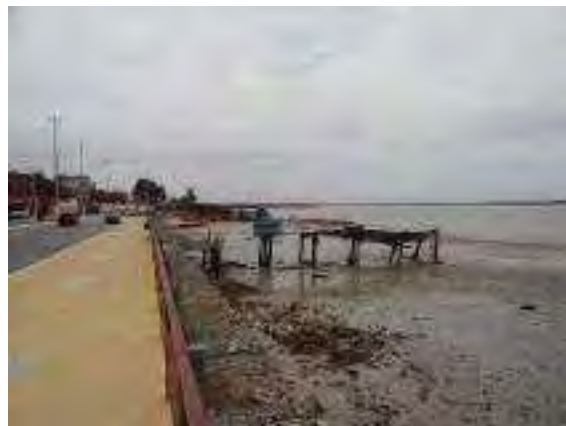
Figura 32: a mesma ponte, em 2016, depois das últimas obras de revitalização da fachada fluvial. Foto do autor.
