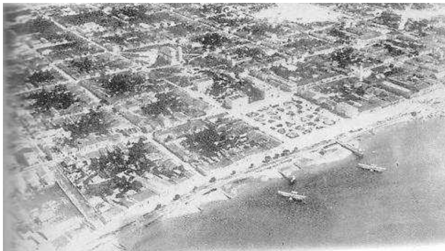
Figura 26: vista aérea, tirada em 1923, mostrando a região ao sul da ponte do Imperador, na extrema direita (MEDINA 1999, p. 73). Em destaque a grande quantidade de pequenas pontes de embarque.
