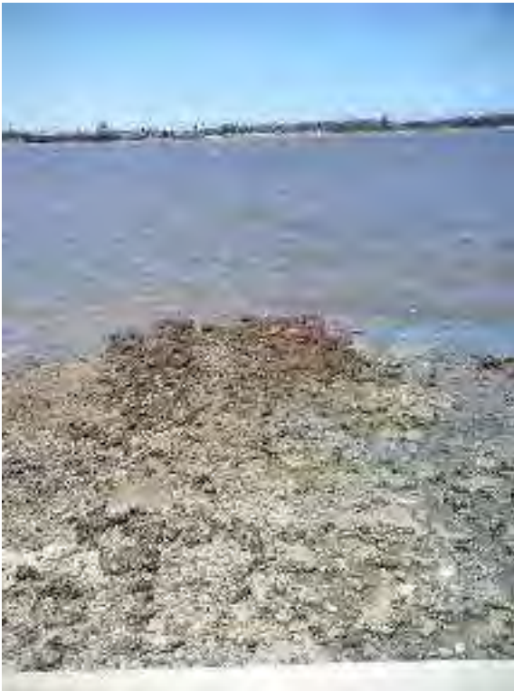
Figura 09: Estrutura 6 – muito próxima da Estrutura 7. Remanescente de estrutura de esgotamento sanitário. Foto do autor, 2016.
