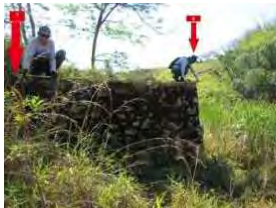
Figura 21: Lado da estrutura com pontos 2 e 3. Foto extraída do Relatório de Prospecção Trecho 2 (Fonte: ECOSSIS, 2015, p. 159).
