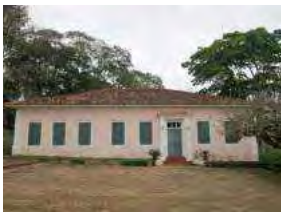
Figura 32: Parte posterior da Sede. Foto extraída do Relatório de Prospecção trecho 2 (Fonte: ECOSSIS, 2015, 108).
