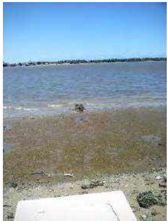
Figura 06: Estrutura 3 – fundação de ponte de embarque. Foto do autor, 2016.
