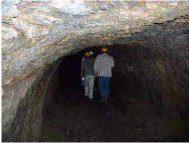
Figura 13: Galeria dos Alargamentos, Trêsminas. Vila Pouca de Aguiar, 2010. A galeria tem 140 m de comprimento por 2 m de largura e 1,5 m de altura (tendo sido aberta a 50 m abaixo do topo da exploração). Recebe esse nome devido a quatro alargamentos que permitiam a passagem de carros de transporte nos dois sentidos que alcançavam as estradas para levar o material à lavagem e trituração.
