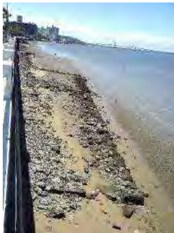
Figura 16: Estrutura 11 - vista sul-norte das fundações do suposto trapiche da fundição Cameron & Smith (1868). Foto do autor, 2016.
