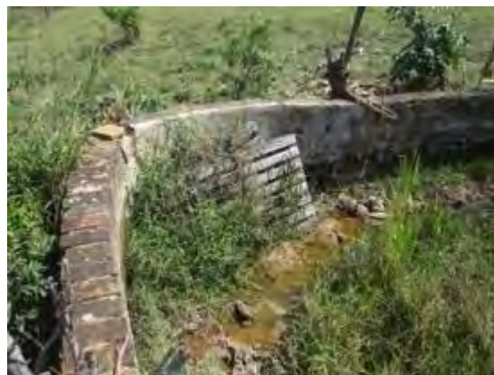
Figura 13: Vértice arredondado da barragem. As técnicas construtivas são recentes. Foto extraída do Relatório de Prospecção Trecho 2 (Fonte: ECOSSIS, 2015, p. 140).
