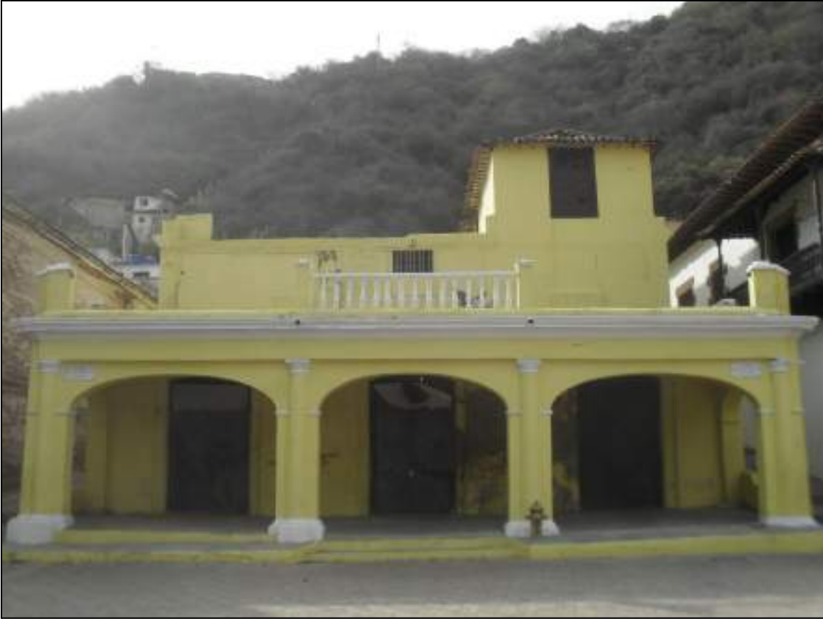
Imagen 5: Edificio Plaza Sucesores, Casco Histórico de La Guaira. Tomada por Humberto Mayora en Junio (2014).
