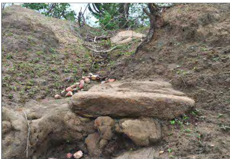
Figura 12: Matações da antiga barragem rejuntados com argamassa de argila. Foto: Celito Kesting, 2013.
