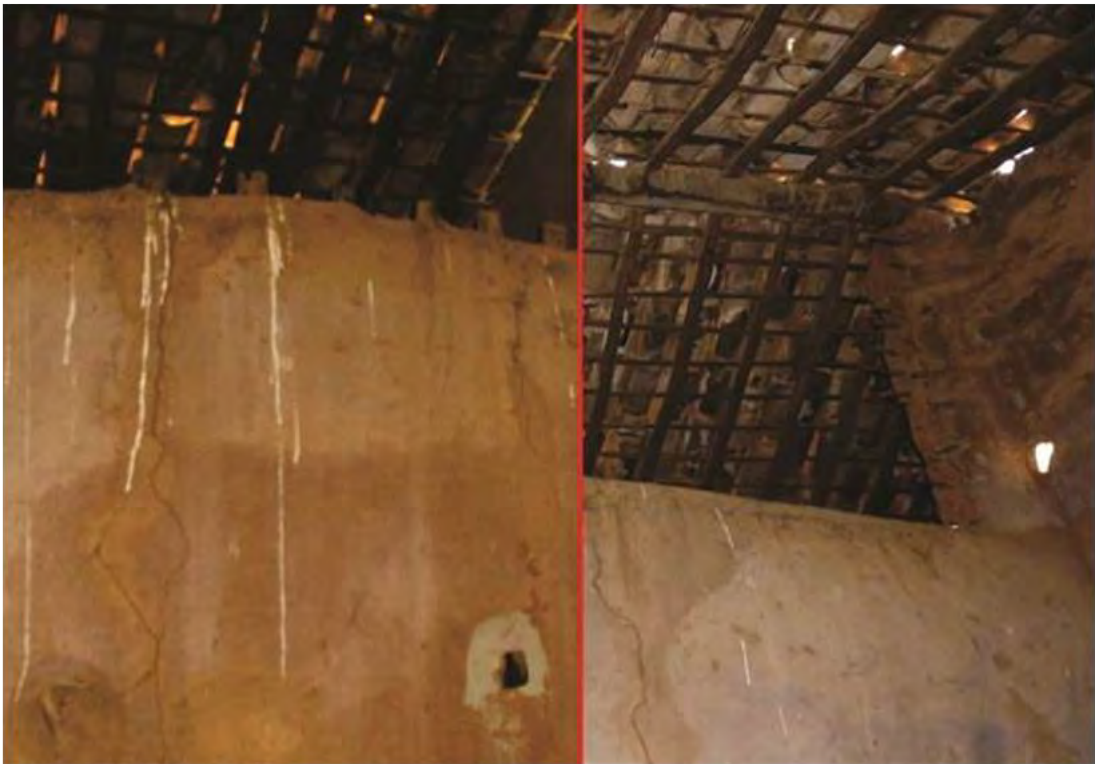
Figura 08: Parede interna de taipa (Foto: RIBEIRO, Marcelo Alves e MACÊDO, Rômulo, 2013)
