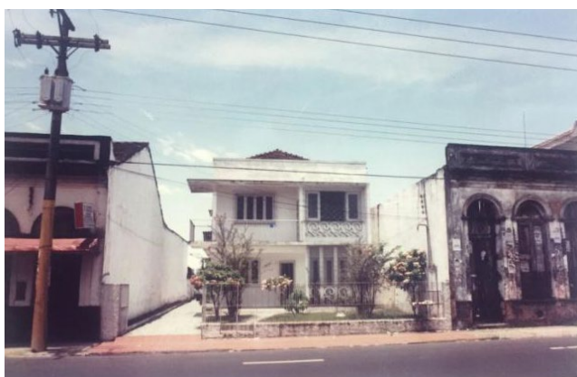
Figura 10. Imóvel localizado entre o CCPRN e a ponte Romana II, em 1997. Fonte: Otoni Mesquita. Acervo Pessoal.
