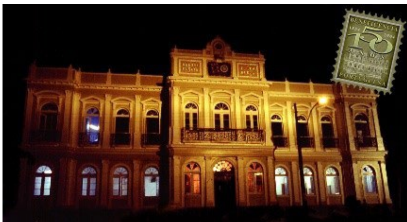
Figura 3: Foto noturna do prédio destacando platibanda cega, corpo principal com brasão. Fonte: Arquivo da Sociedade Portuguesa de Beneficência de Porto Alegre.
