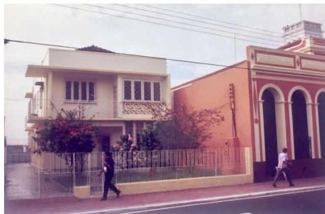
Figura 14. Imóvel após a restauração, localizado entre o Palácio Rio Negro e a ponte Romana II, em 1998. Fonte: Otoni Mesquita. Acervo Pessoal.
