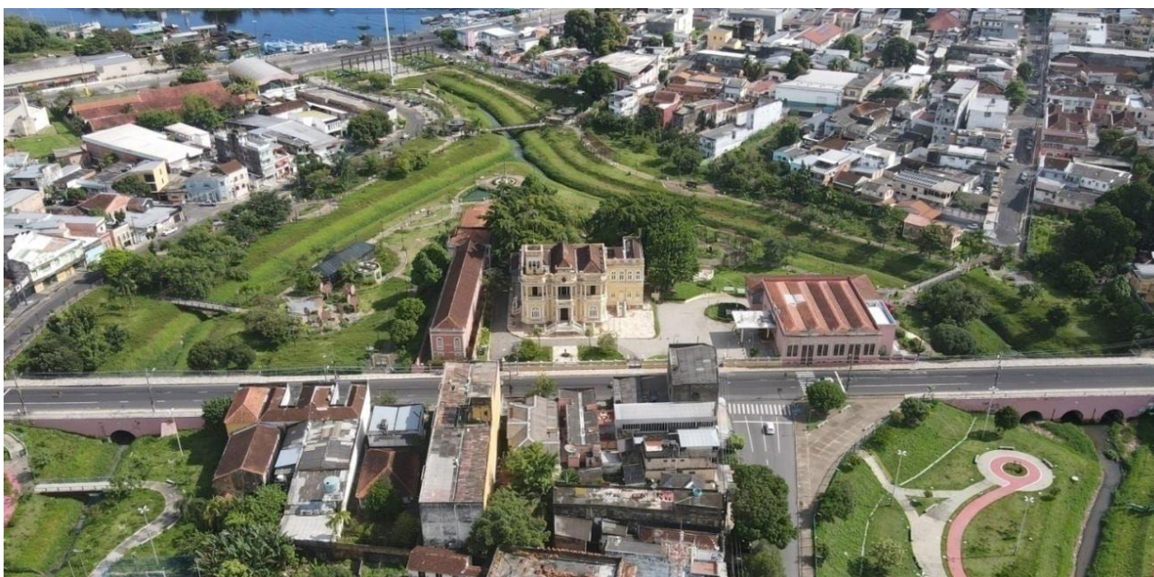
Figura 22. Imagem aérea do entorno do Centro Cultural Palácio Rio Negro e Parque Senador Jefferson Péres. Registro realizado por meio de drone em 2021. Fonte: A autora, 2021.
