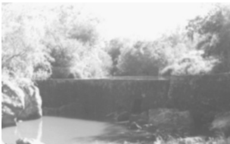
Foto 07: Represa da Pedra, segundo fontes orais, teria sido construída por escravos.
