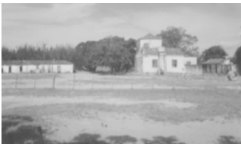
Foto 09: Sede da Estância da Sotéia, construída provavelmente no início do século XIX.
