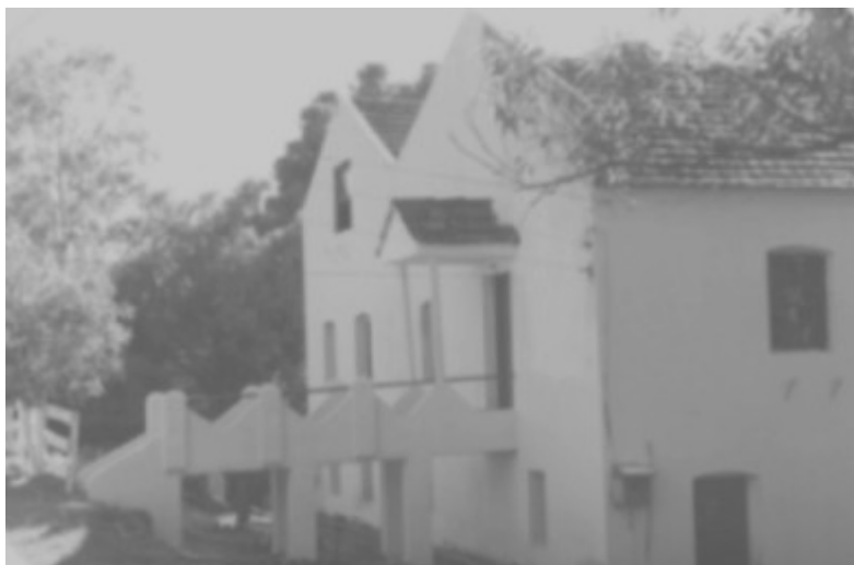
Foto 06: Casa em estilo colonial situada na margem direita do Arroio do Ouro, no sentido Leste/Oeste.
