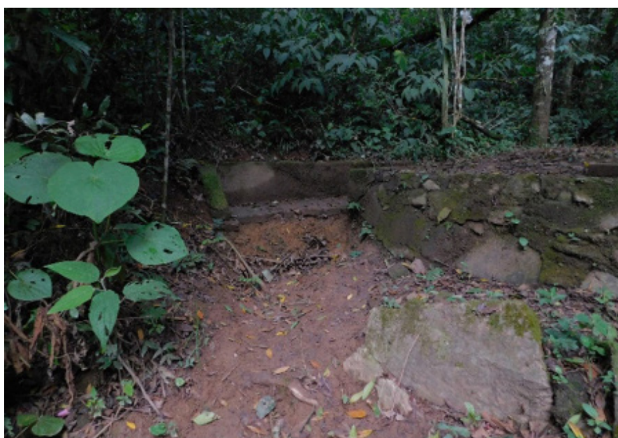
Figura 8. Muro de pedra presente na barragem, indicando métodos construtivos mais modernos. Imagem: Tiago Attorre (2019).
