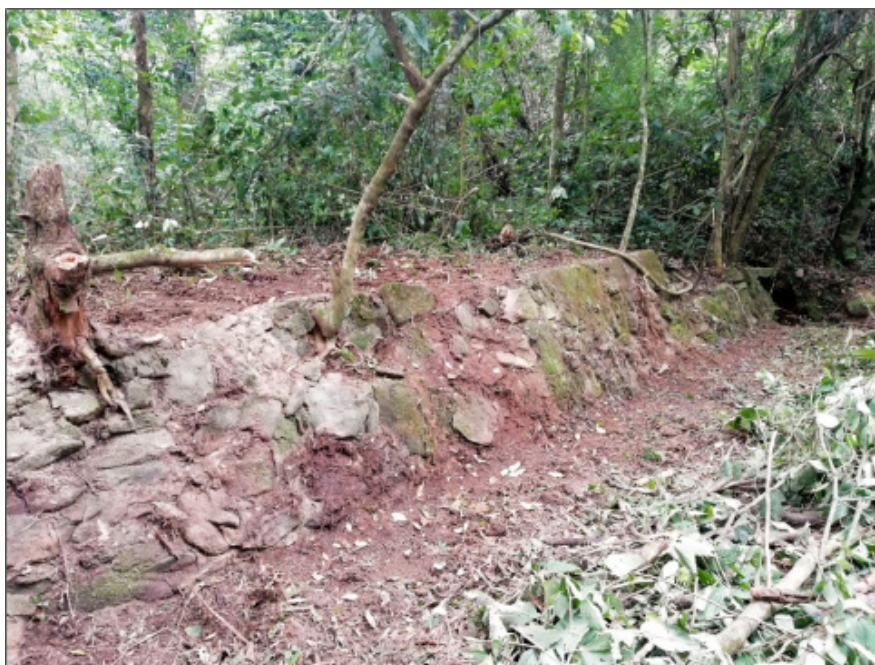
Figura 10. Vista parcial da barragem após limpeza da vegetação. Imagem: Tiago Attorre (2019).
