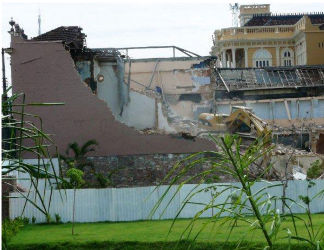
Figura 17. Foto tirada em janeiro de 2010 casarões geminados sendo demolidos. Foto: Clara Nihil. Fonte: Blog Palavra do Fingidor. Disponível em: http://palavradofingidor.blogspot.com/2010/01/crime-de-lesa-patrimonio.html
