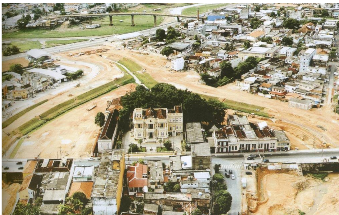
Figura 16. Entorno do CCPRN, obras de aterramento e revitalização realizadas pelo PROSAMIM, em 2008. Ao fundo, a ponte Padre Antônio Plácido. Foto: Mario de Oliveira. Acervo: Agecom. Fonte: Durango Duarte, 2009.
