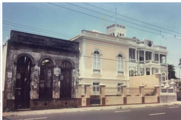
Figura 9. Edificações localizadas entre o CCPRN e a ponte Romana II, em 1997. Fonte: Otoni Mesquita. Acervo Pessoal.
