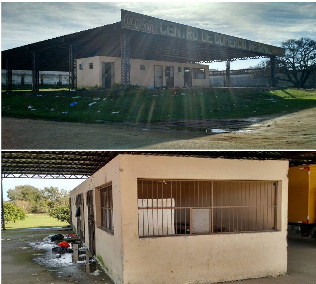
Figuras 2 e 3 – Fachada sul do galpão municipal e construção em alvenaria.
