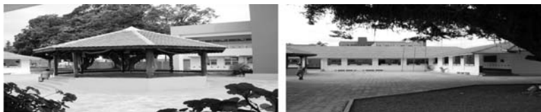
Ambiente da escola limpo e arejado (estrutura física nova e/ou reformada)
