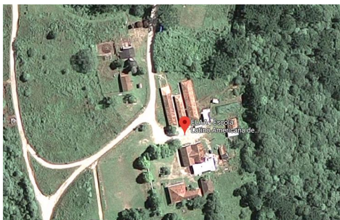
Figura 04 – Imagem satelital de parte da Sede Comunitária do Assentamento Contestado, onde localizam-se as principais estruturas comunitárias do mesmo. Fonte: Google Maps (2018).
