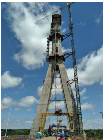
Imagem 05 : Ponte da Integração (Brasil/Paraguai), em adiantada fase de construção. Fonte: Cecilia Angileli, visita ao canteiro de obras em outubro de 2021
