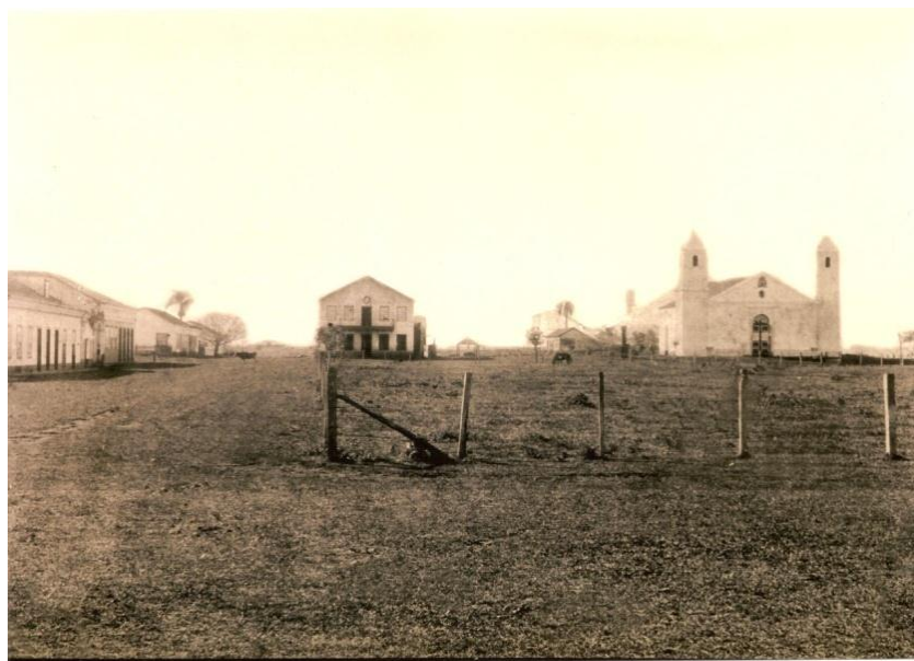
Figura 2 - Igreja construída em 1888. Ao lado esquerdo encontra-se a Intendência Municipal e em frente, a Praça. Fonte: Arquivo Histórico Municipal Augusto César Pereira
