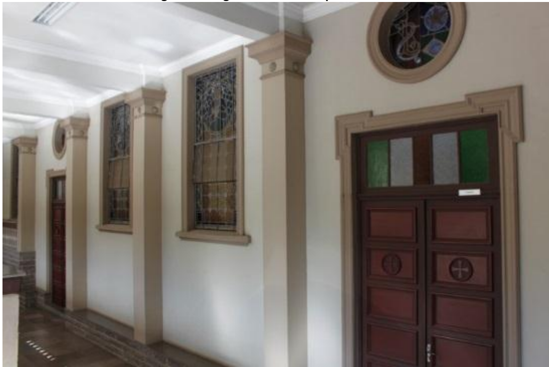
Figura 2: Imagem externa da Capela São José.
