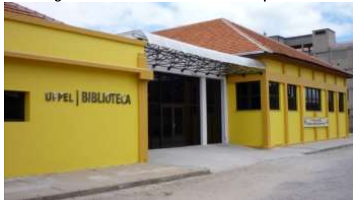
Figura 14 - Prédio da biblioteca do Campus Porto
