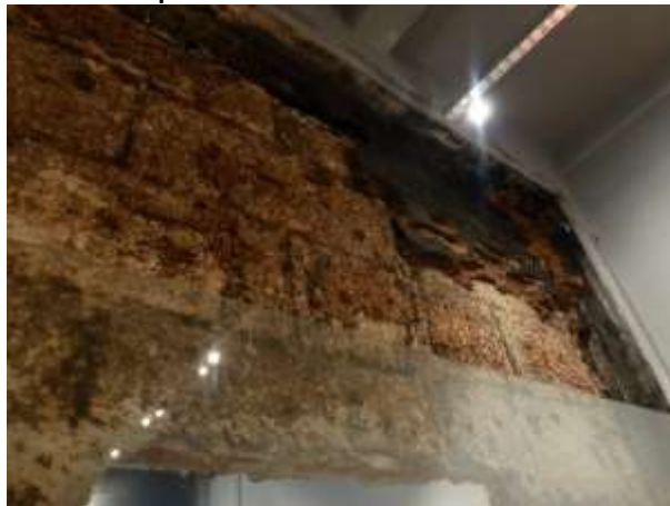
Figura 18 - Mostra da parede da câmara fria no Memorial do Anglo, UFPel
