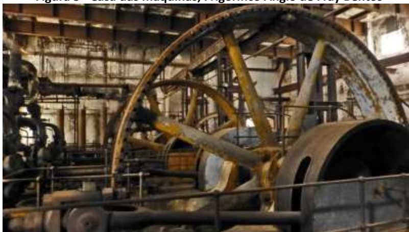
Figura 5 - Casa das máquinas, Frigorífico Anglo de Fray Bentos
