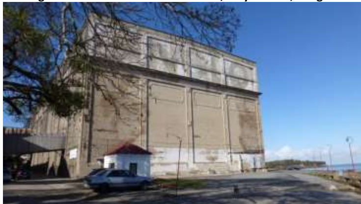
Figura 19 - Prédio das câmaras frias, Fray Bentos, Uruguai
