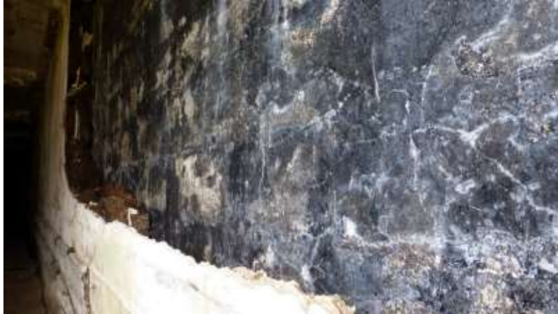
Figura 20 - Parede interna mostrando o revestimento, Fray Bentos, Uruguai
