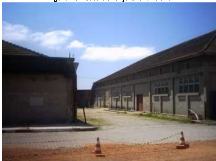
Figura 13 - Casa de força e lavanderia
