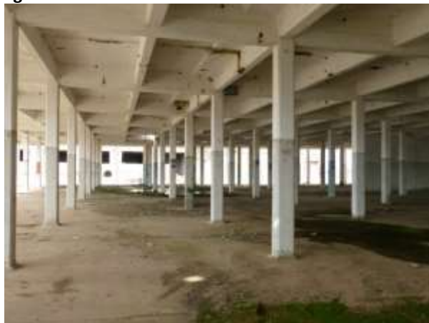
Figura 6 - Prédio onde funcionava a sessão de conservas
