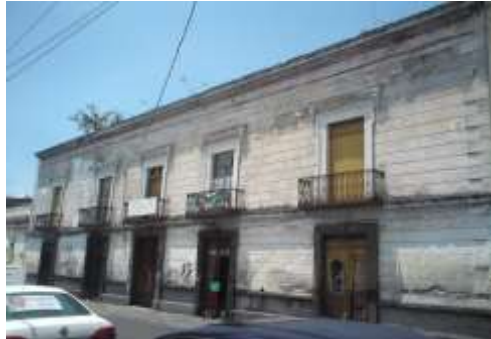
Figura 8. Exterior del inmueble 13 poniente 107
