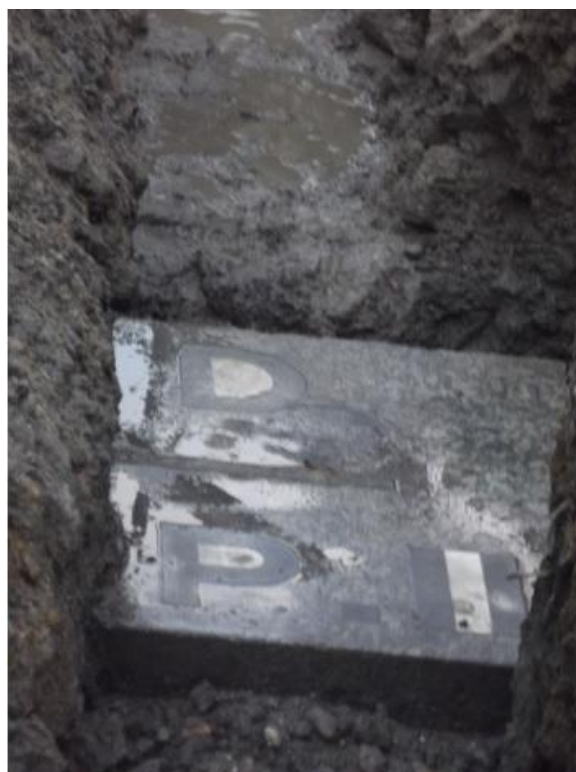
Figura 1 - O surgimento inesperado do bloco de granito lavrado em meio a escavação da trincheira para implantação da rede de esgoto.
