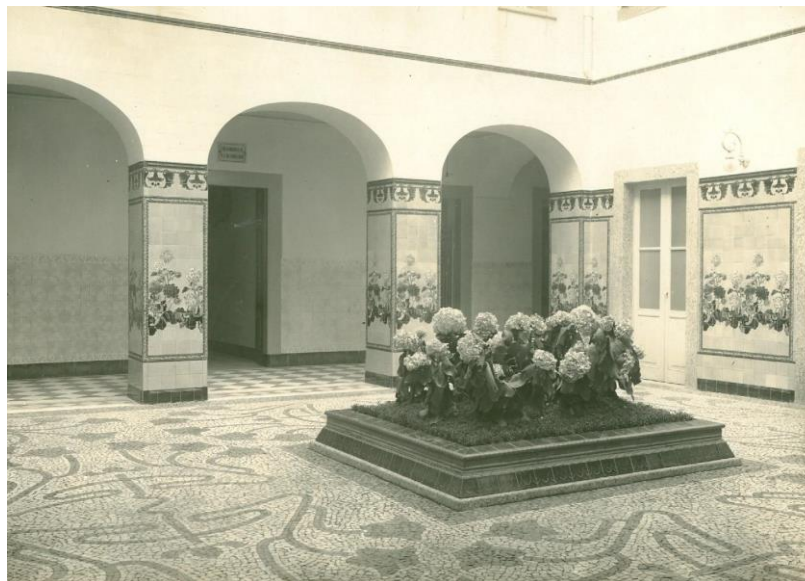
Figura 9 – Pátio interno com azulejos belgas e calçamento em pedras portuguesas
