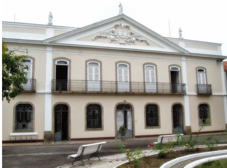
Figura 6 – Fachada posterior do Hospital Frei Antônio
