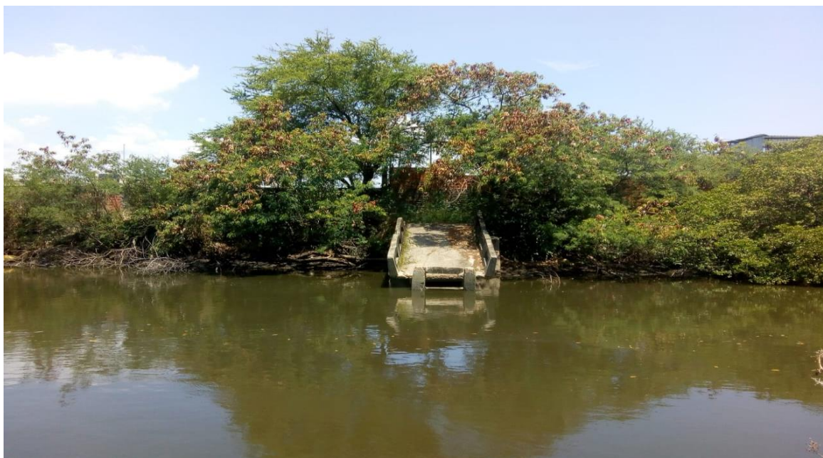
Figura 2 - Ponte desativada, sobre o Rio Poxim.
