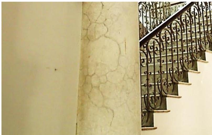
**Figura 36:** Detalhe do fuste de uma coluna decorado com escaiola, no pavimento térreo. **Fonte:** Foto de Fábio Galli, 2015.
