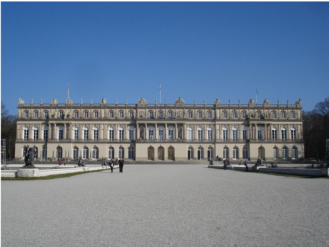
Figura 16: Aspecto da fachada do palácio de Herrenchiemsee, voltada para o jardim. Fonte: Foto do autor, 2014.
