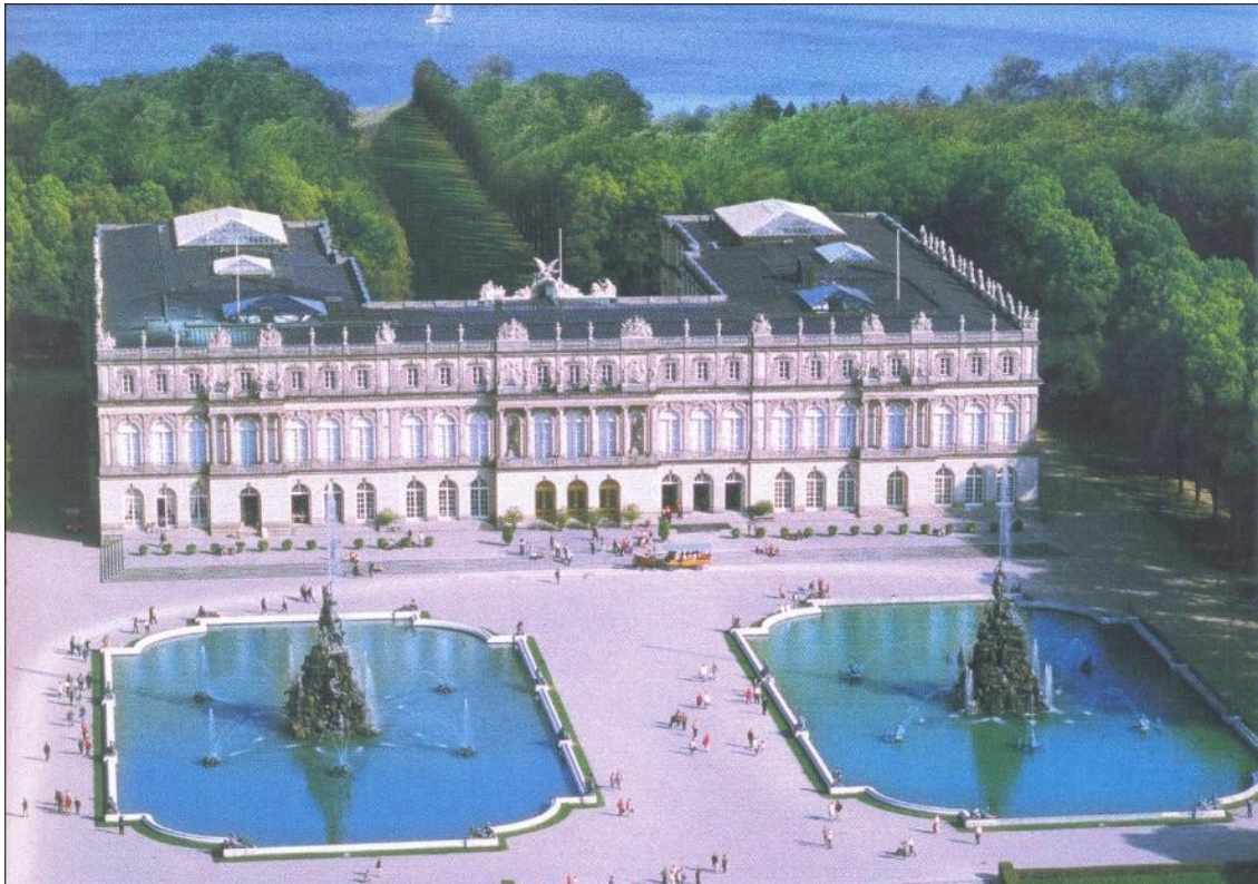
Figura 18: A caixa mural de Herrenchiemsee. Notem-se as estruturas das coberturas zenitais, no telhado Fonte: KIENBERGER, Klaus. Neuschwanstein, Linderhof, Herrenchiemsee: les châteaux et la vie du roi Louis II de Bavière. Munich: Verlag Kienberger Lechbruck, 1976, p. 96.
