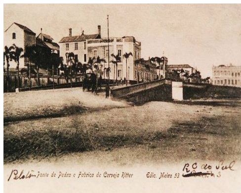
Figura 3: Na imagem à esquerda, Ponte do arroio Santa Bárbara, na Rua Marechal Floriano.
