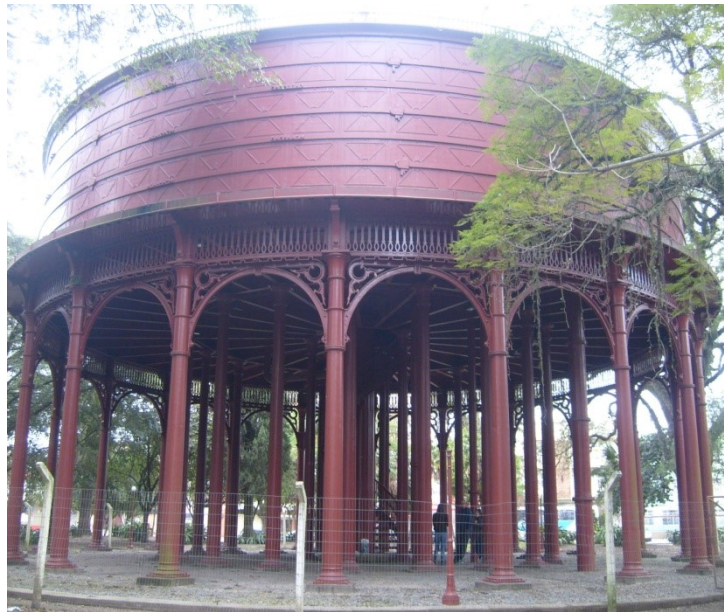
Figura 12: Reservatório da Praça Piratinino de Almeida. Fonte: Foto da Autora, 2015.
