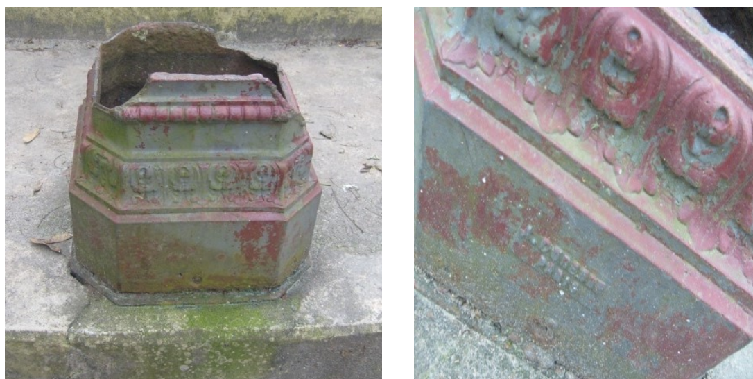
Figura 10: As estruturas que sobraram dos quatro postes da iluminação. Fonte: Fotos da autora, 2015
