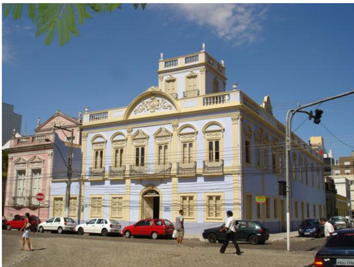
Figura 11: Fachada principal da antiga residência do Barão de Butuí. Fonte: Foto do autor, 2010.
