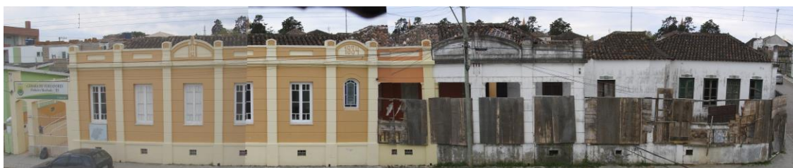
Figura 4: Vista panorâmica da fachada secundária: à esquerda, parte do prédio que pertence à Câmara de Vereadores, à direita, parte do prédio que pertence à Prefeitura Municipal de Pinheiro Machado. Fonte: acervo do NEAB, 2013.
