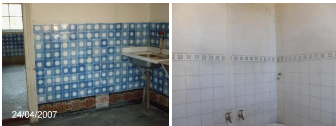
Figura 10: Na imagem à esquerda, 1: Revestimento de azulejos sobre as paredes da cozinha. Na imagem à direita, 2: Detalhe de escaiola que imita azulejaria sobre as paredes do banheiro. Fonte: Fotos de Fabio Galli, 2007.
