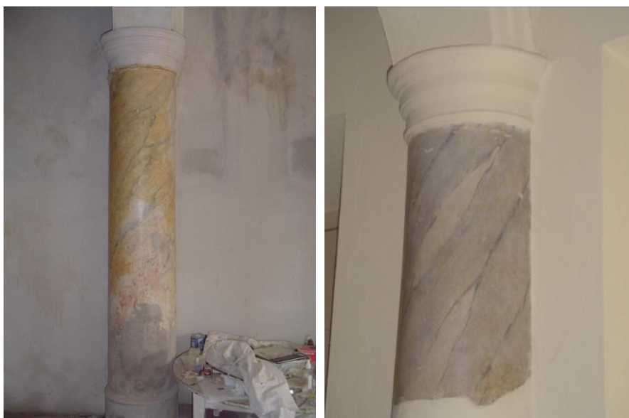
Figura 12: Na imagem à esquerda, 1: Aspecto da escaiola que reveste o fuste de uma das colunas do hall, que utiliza tons de ocre. Na imagem à direita, 2: Detalhe da escaiola que cobre o fuste de uma das colunas que sustentam o arco de acesso à escada, que explorou tons de cinza. Fonte: Fotos de Fabio Galli, data?
