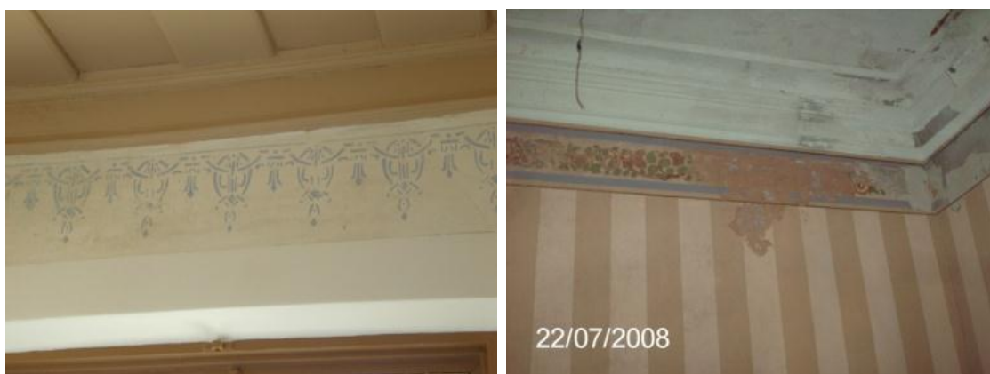
Figura 9: Na imagem à esquerda, 1: Friso decorativo executado na técnica do estêncil. Na imagem à direita, 2: Pintura decorativa com friso elaborado na mesma técnica. Fonte: Fotos de Fabio Galli, 2008.
