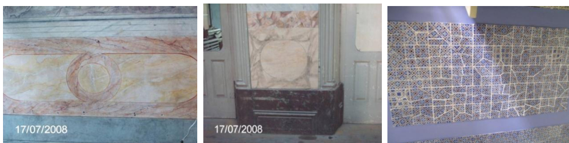
Figura 7: Na imagem à esquerda, 1: Detalhe de escaiola que explora formas geométricas. Na imagem central, 2: Detalhe de escaiola com o rodapé de madeira marmoreada. Na imagem à direita, 3: Detalhe do revestimento de azulejos. Fonte: Fotos de Fabio Galli, 2008.
