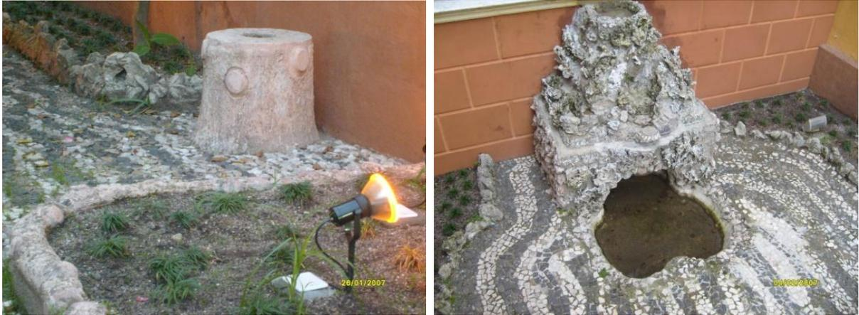
**Figura 12:** Na imagem à esquerda, 1: Pedestal de vaso em alvenaria, que imita um tronco de árvore. Na imagem à direita, 2: Pequena gruta e fonte moldadas em alvenaria de tijolos e cimento, ornadas com a técnica dos embrechados. **Fonte:** Fotos da autora, 2013.
