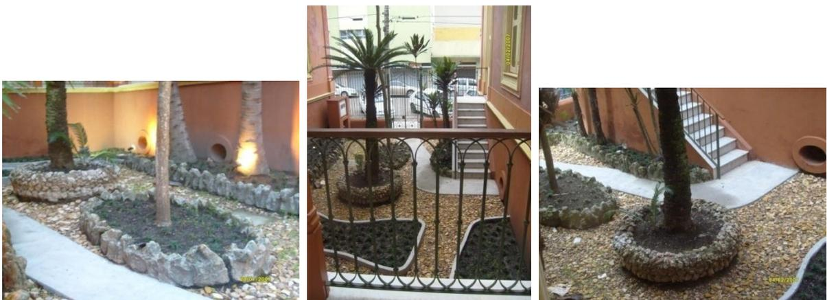
**Figura 13:** Na imagem à esquerda, 1: Os limites dos canteiros com bordadura em alvenaria de tijolos e cimento imitando pedras, no jardim voltado para a Rua Barão de Butuí. Na imagem central, 2: Aspecto do jardim. Na imagem à direita, 3: Os limites dos canteiros na técnica dos embrechados. **Fonte:** Fotos da autora, 2013.
