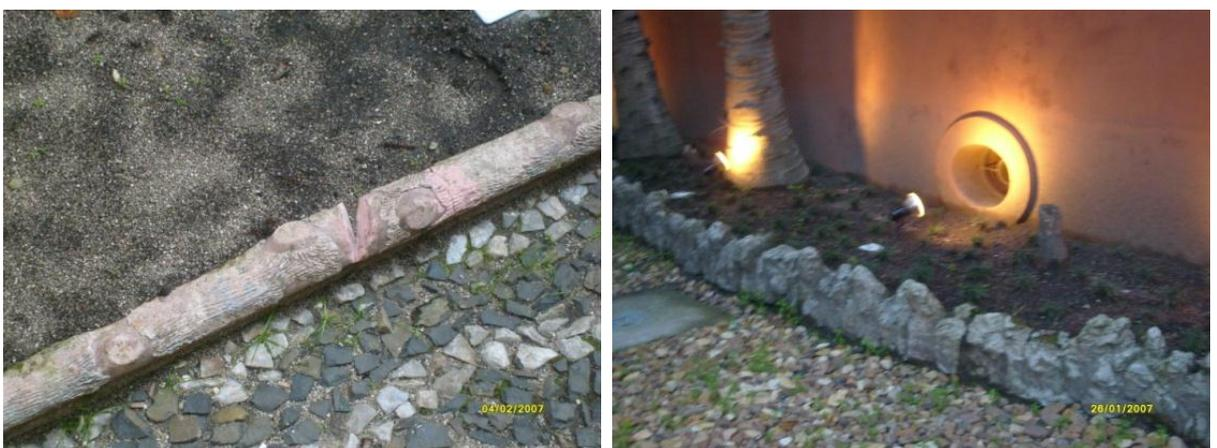
**Figura 11:** Canteiros com contorno revestido com elementos decorativos elaborados em alvenaria de tijolos e cimento, imitando troncos de árvores ou pedras. **Fonte:** Fotos da autora, 2013.
