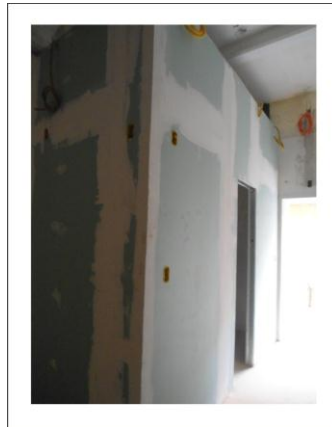
Figura 3: O gesso acartonado foi utilizado para dividir as suítes. Fonte: Foto da autora, 2013.
