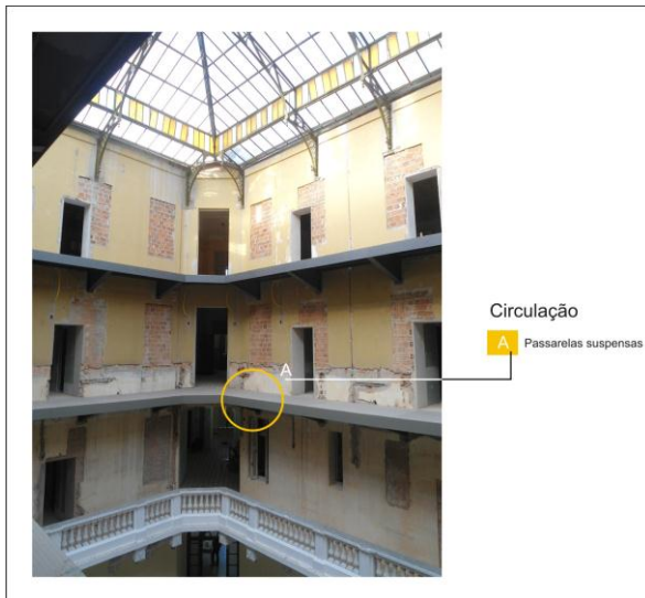
Figura 4: As passarelas de aço criaram uma nova área de circulação para o 2º e 3º pavimentos, mas, interferem na iluminação do ambiente. Fonte: Foto da autora, 2012.
