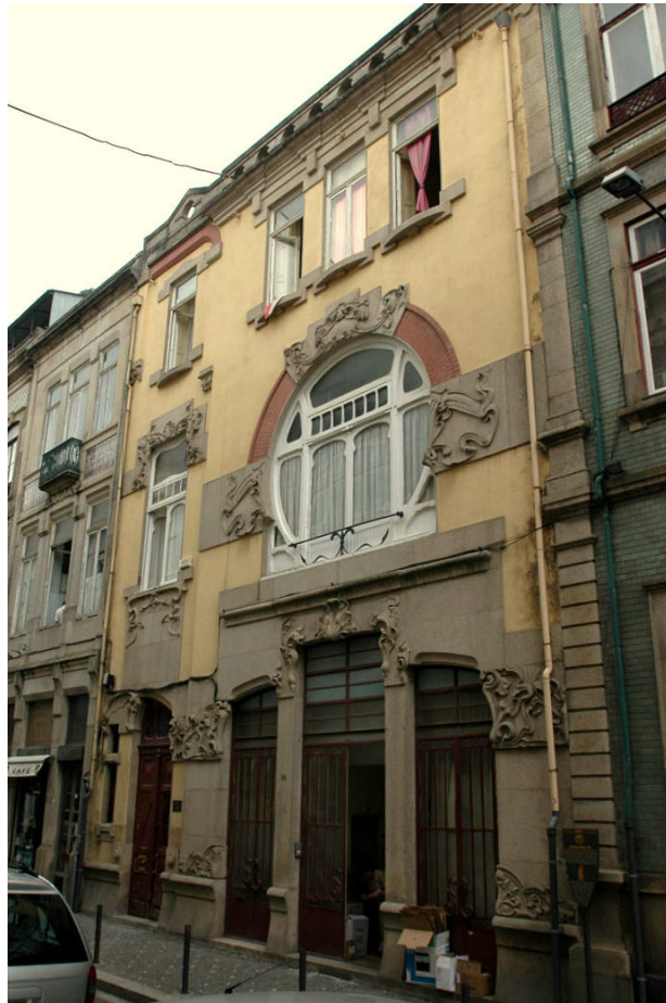
Figura 1 – Casa Amarela na Rua Galeria de Paris 1
