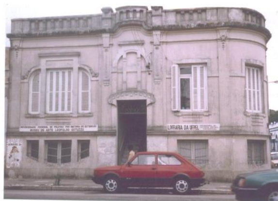
Figura 5: Primeira sede do MALG (11/1986-02/1992), Rua Marechal Deodoro, 763. Fonte: Arquivo MALG
