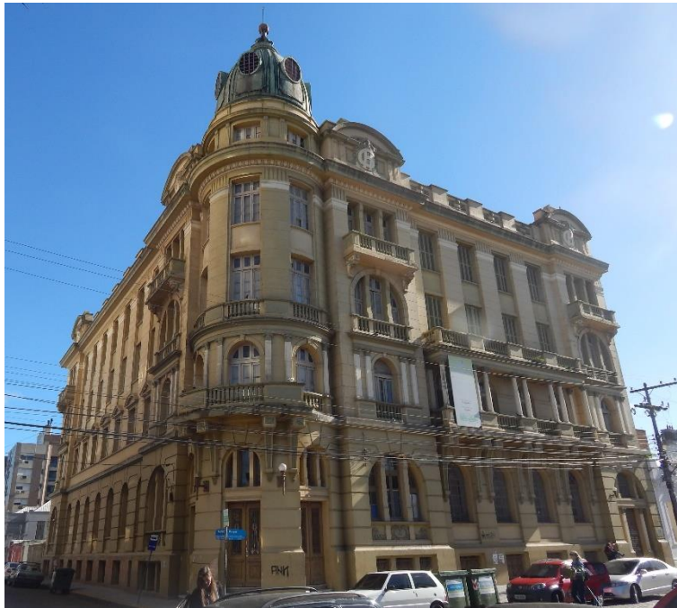
Figura 11: Grande Hotel, construído em 1925. Fonte: Autor, 2019.
