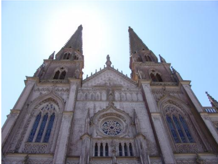
Figura 2 Vista Frontal da Igreja do Carmo
