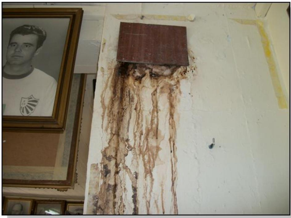
Figura – 2: Infiltrações no Concreto
