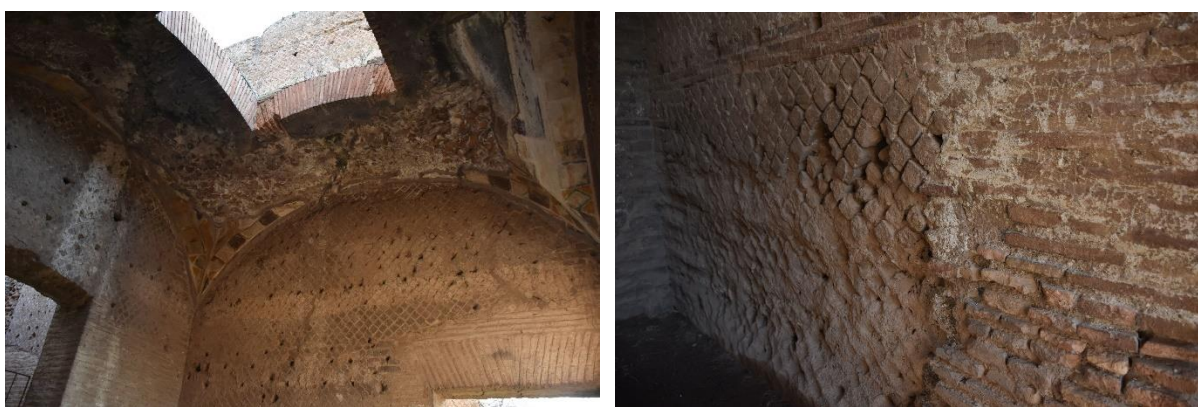
Figura 11: Nas duas imagens: Os tijolos retangulares colocados na horizontal sobre as laterais dos vãos. E dispostos em diagonal nas vergas e, no arremate do óculo da cúpula. No restante das superfícies murais, dispostos na posição de losangos. Fonte: Fotos do autor.
