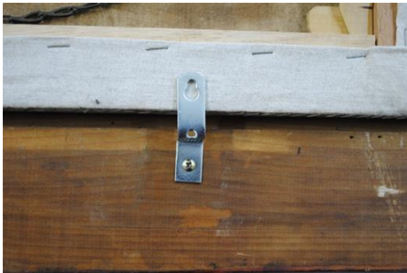
Figura 21: Gancho e parafuso usados para fixar a tela na moldura (2017). Fonte: Autoral.
