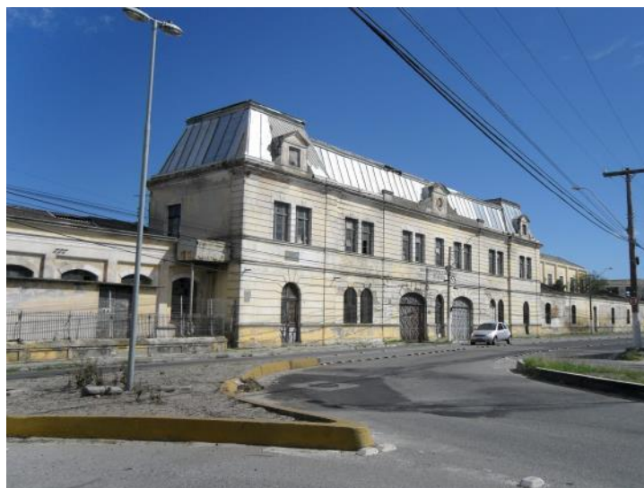
Figura 2: Fachada Principal da Companhia União Fabril. No centro, o Edifício do Escritório Fonte: Acervo das autoras, 2017.
