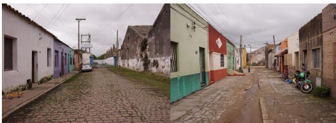
Figura 6: Na imagem à esquerda, 1: Casas do Corredor voltadas para a lateral da fábrica. Fonte: Acervo das autoras, 2016. Na imagem à direita, 2: Casas do Corredor situadas na rua paralela à Avenida Rheingantz. Fonte: Acervo das autoras, 2017.
