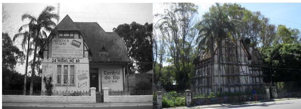
Figura 15: Na imagem à esquerda, 1: Jardim de Infância. Fonte: Acervo de Oscar Décio Carneiro. Na imagem à direita, 2: O Jardim de Infância em 2016, bastante deteriorado. Fonte: Acervo das autoras
