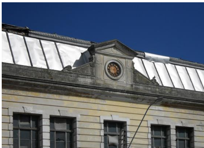
Figura 3: Detalhe do relógio disposto no centro da Fachada Principal. Fonte: Acervo das autoras, 2017.
