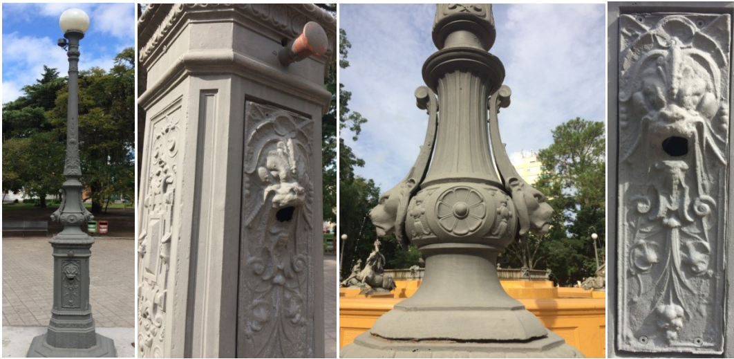
Figura 4: da esquerda para direita: o poste, mecanismo para acionar a saída de água, as cabeças de leões, a gárgula.
