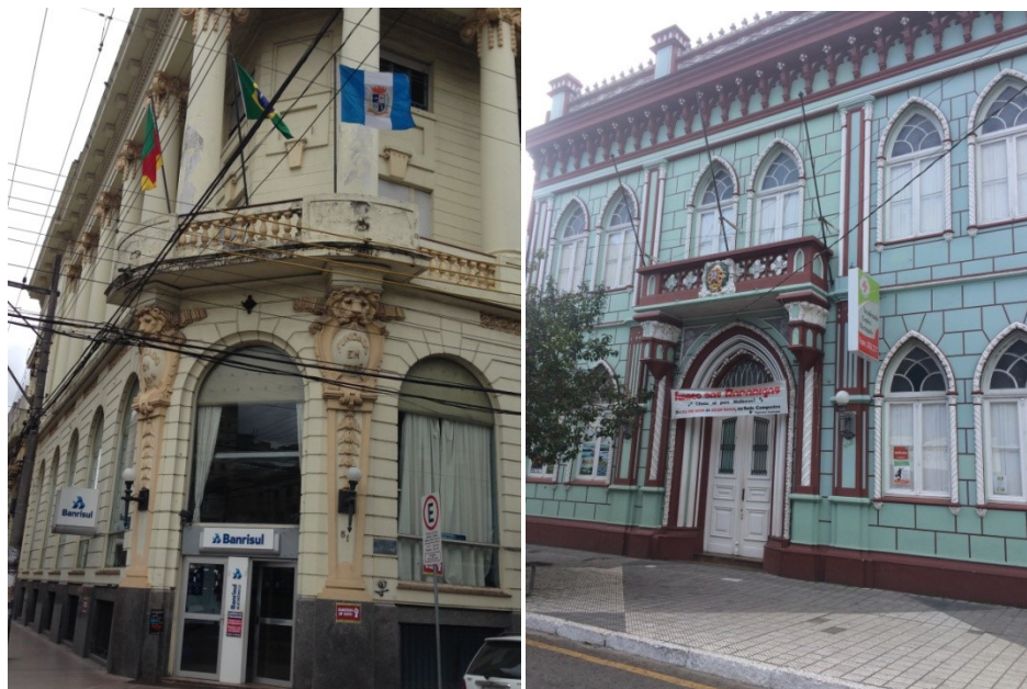
Figura 7: A esquerda, hoje Banrisul, construído para agência do Banco Pelotense; à direita O clube Centro Português localizado no mesmo prédio desde sua construção. Em ambos as luminárias estão ao lado da porta de entrada.
